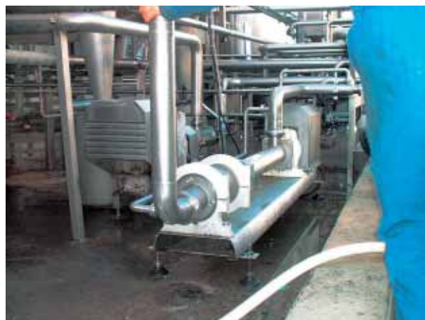
25H6 dans l'industrie laitière pour le déchargement d'huile alimentaire vers un tank de stockage.
